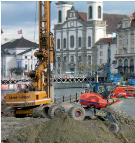
Lärmintensive Arbeiten am Reusswehr
