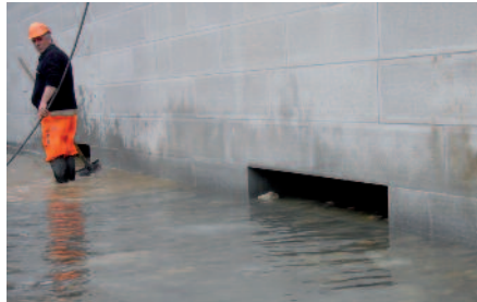
Neue Fischunterstände in der Trennselmauer bei abgesenktem Wasserstand
