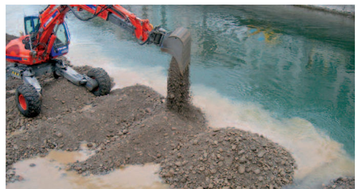
Schüttung der Baupiste
